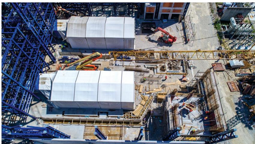
← U budućoj strojarnici na temelje su postavljene dvije plinske turbine i pripadajući generatori koji su potom zaštićeni pokrovom
