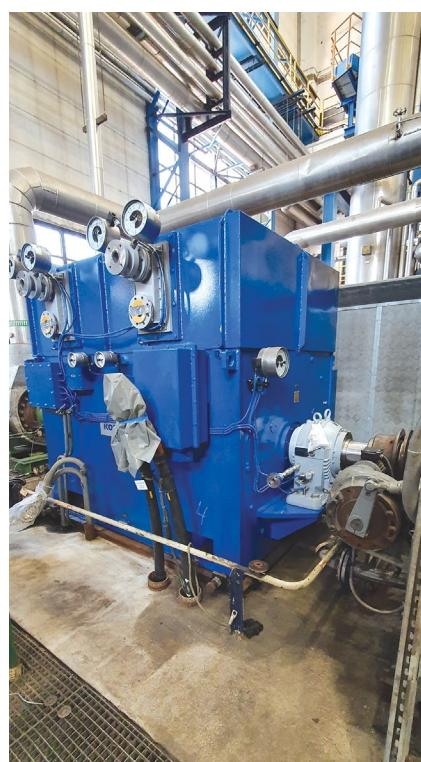
↑ Novi elektromotor postavljen je u napojni agregat br. 3
