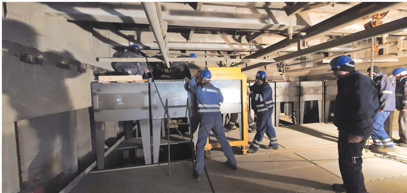
↑ Ugradnja paketa katalizatora DENOX sustava
