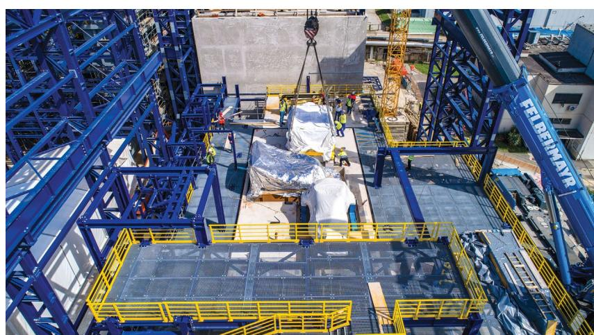
↑ U strojarnici novog bloka nakon postavljanja generatora parne turbine, reduktora i parne turbine
